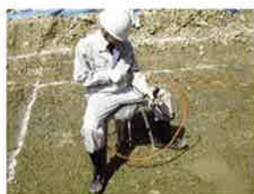
「エレフト」による支持力試験
