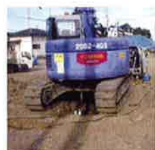
重機を使った平板荷重試験
