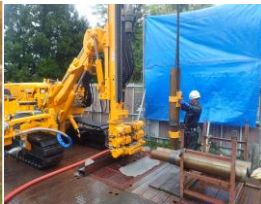
ケーシング固定装置を使った工事の様子
