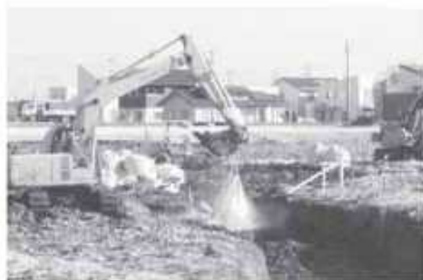
石粉を利用したため池底泥改良材施工状況
