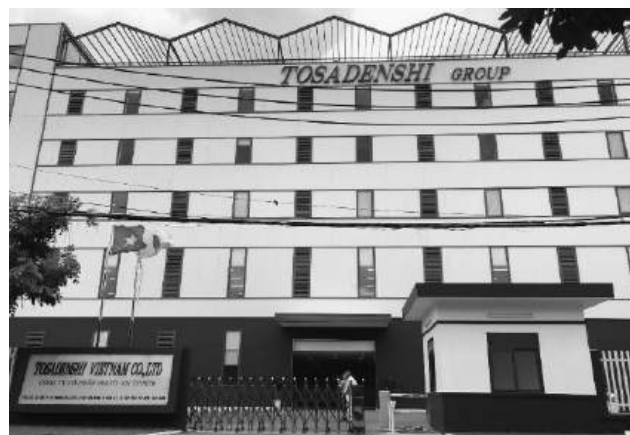
TOSADENSHI VIETNAM LTD 新工場社屋
