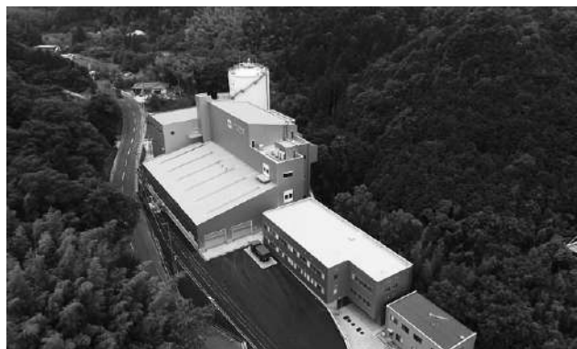
乾式メタン発酵施設の全景
