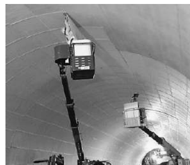
高所作業者をを用いた 養生粘着シートの貼付状況
