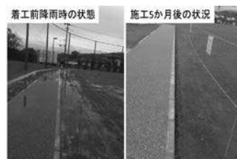
排水改善システムの 施工前と施工後
