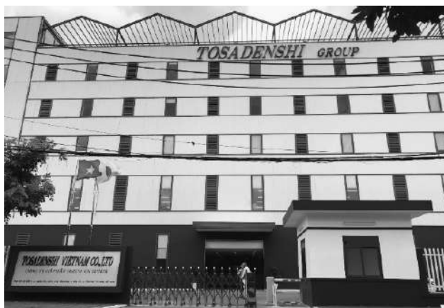
TOSADENSHI VIETNAM LTD 新工場社屋
