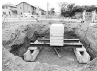
平板載荷試験の実施状況 (反力 20 tH 鋼・コンクリート塊) 大規模な平板載荷試験の実施状況
