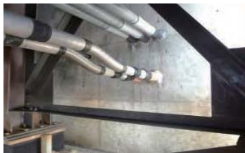
橋梁部の耐震対策
