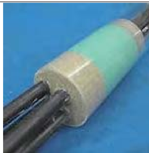
管路内の止水状況
