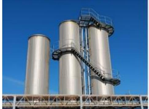
【EGSB処理方式（酸生成槽/反応槽）】
