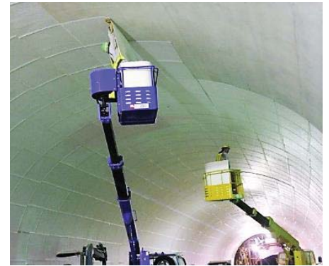
高所作業者をういた養生粘着シートの貼付状況
