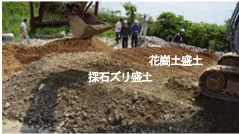
図-1 盛土の築造状況
